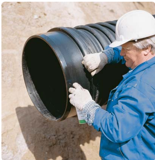
3. Stryk smörjmedel på rörets spetsända.
