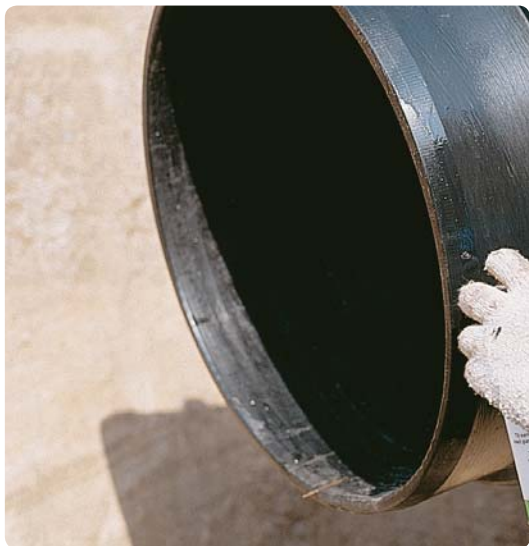
1. Kontrollera röret med avseende på transportskada eller annan skada.
