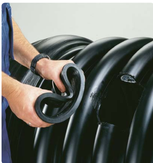
2. Manschetten monteras
