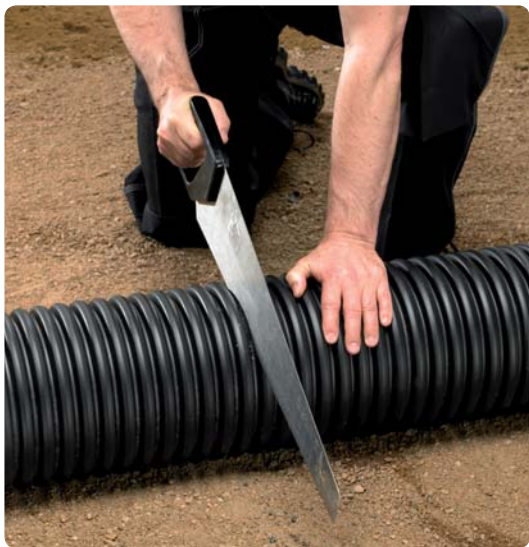
1. Röret sågas av mellan 2 ribbor med fogsvans.
