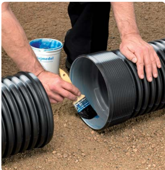
3. Muffen smörjs invändigt med smörjmedel.
