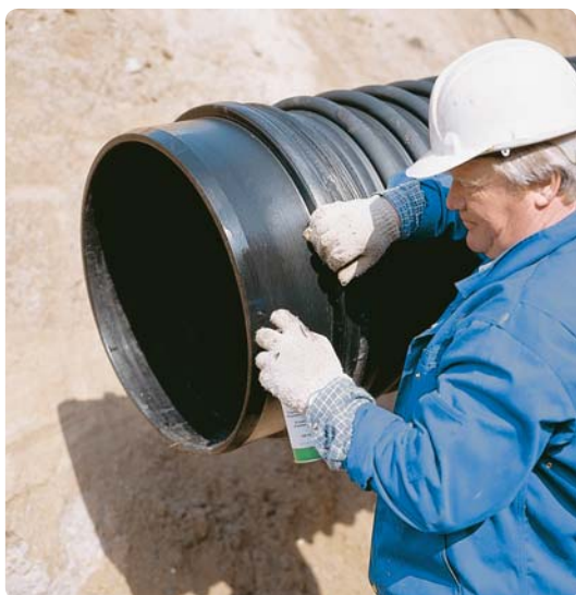
3. Stryk smörjmedel på rörets spetsända.
