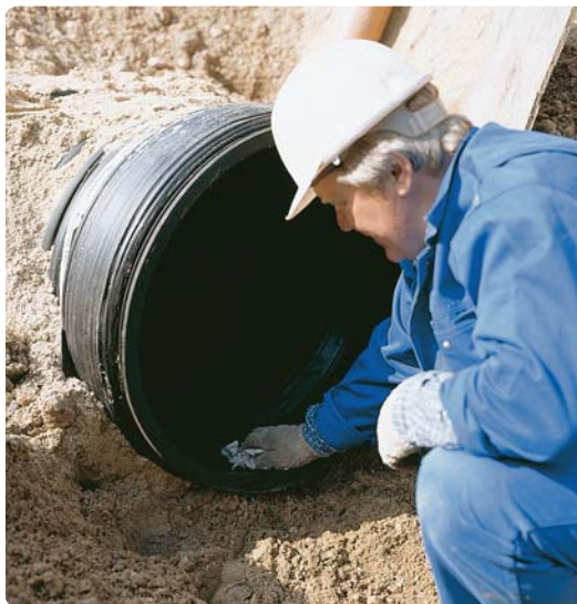
2. Rengör spetsända, muff och tätning-ring från sand och grus.
