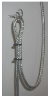
Fig. 6. Exempel på kabelupphängning
