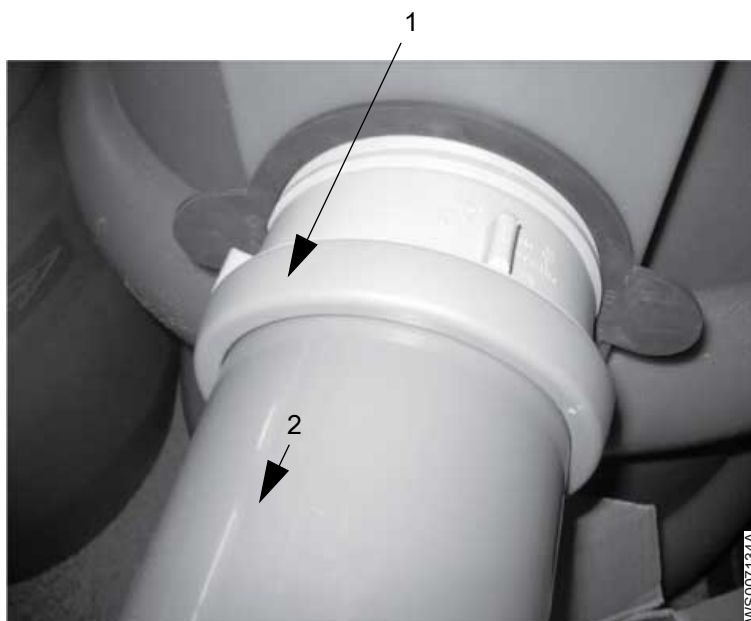
Figur 5: Inloppsrör diameter 110 mm
